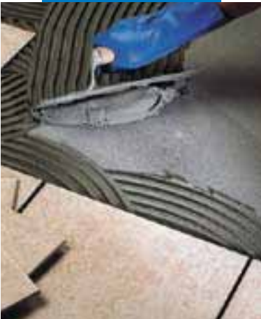
Posa di monocottura a pavimento
