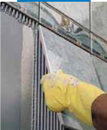
Posa di monocottura a parete su cartongesso
