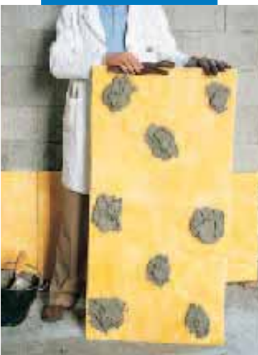
Incollaggio di pannelli isolanti su muro grezzo
